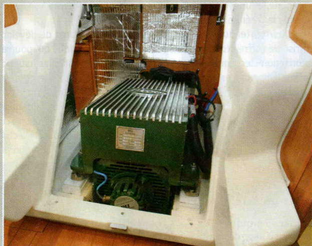
▲ La cale, prévue pour un moteur diesel, paraît immense pour un électrique.
