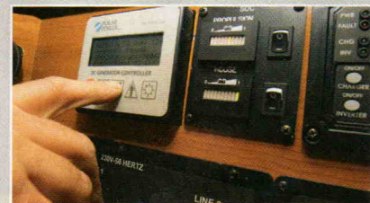
▲ Le démarrage du moteur se fait depuis le calculateur placé à la table à cartes.
